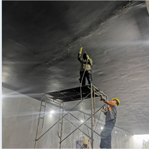
Injeksi kebocoran atap PABRIK BAJA TANGERANG
