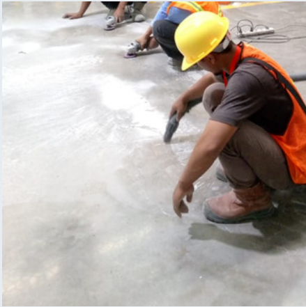
Injeksi kebocoran lantai basement mall, Jakarta Pusat 2020
