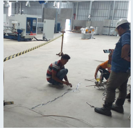
Injeksi lantai retak pabrik tekstil Banten 2023
