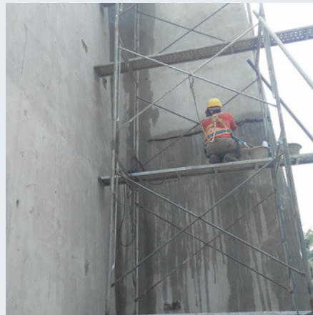
Injeksi keretakan beton bangunan PT. Jotun Indonesia 2018
