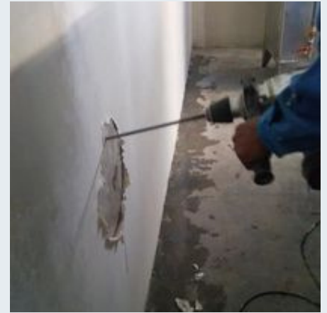
Injeksi kebocoran basement Toserba Kota Bandung 2019
