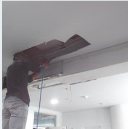
Injeksi kebocoran atap rumah tinggal Margahayu Raya, Bandung 2020
