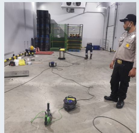
Grouting kebocoran kantor Samsat Bandung Timur 2022
