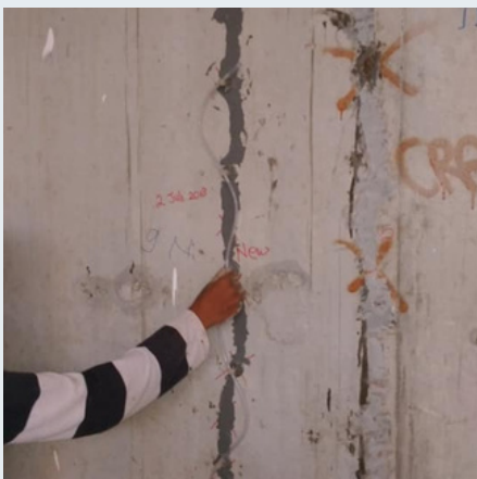
Injeksi keretakan dinding rumah Kost , Bandung 2019
