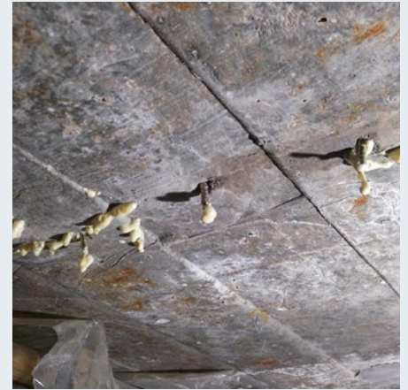
Injeksi kebocoran atap rumah tinggal, kota bandung 2018
