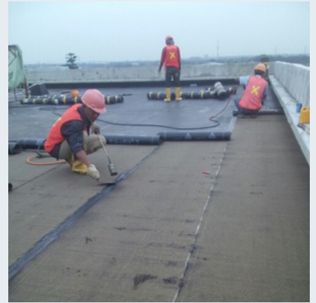
Waterproofing membrane atap masjid Kota Bandung 2020
