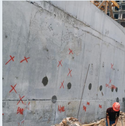
Injeksi kebocoran dinding bandara Kertajati, Majalengka 2022
