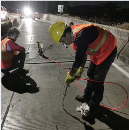
Grouting jalan bandara Kertajati, Majalengka 2022
