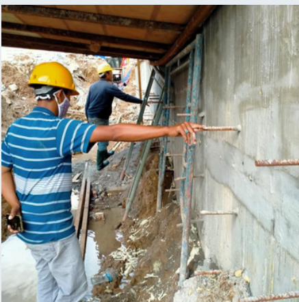
Injeksi keretakan dinding rumah tinggal Kelapa gading, Jakarta Pusat 2021
