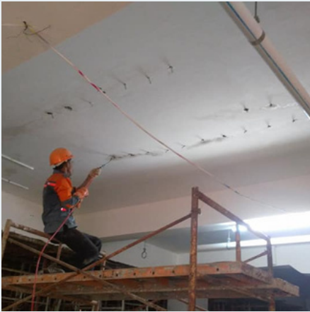
Injeksi kebocoran rumah tinggal Punclut, Lembang 2019
