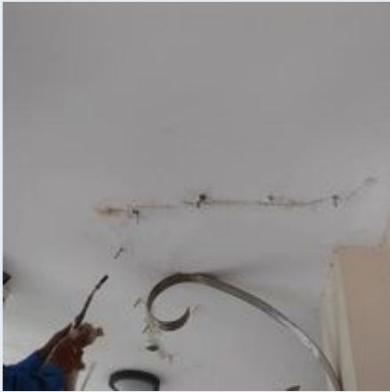
Injeksi kebocoran atap rumah tinggal Kelapa Gading, Jakarta 2020
